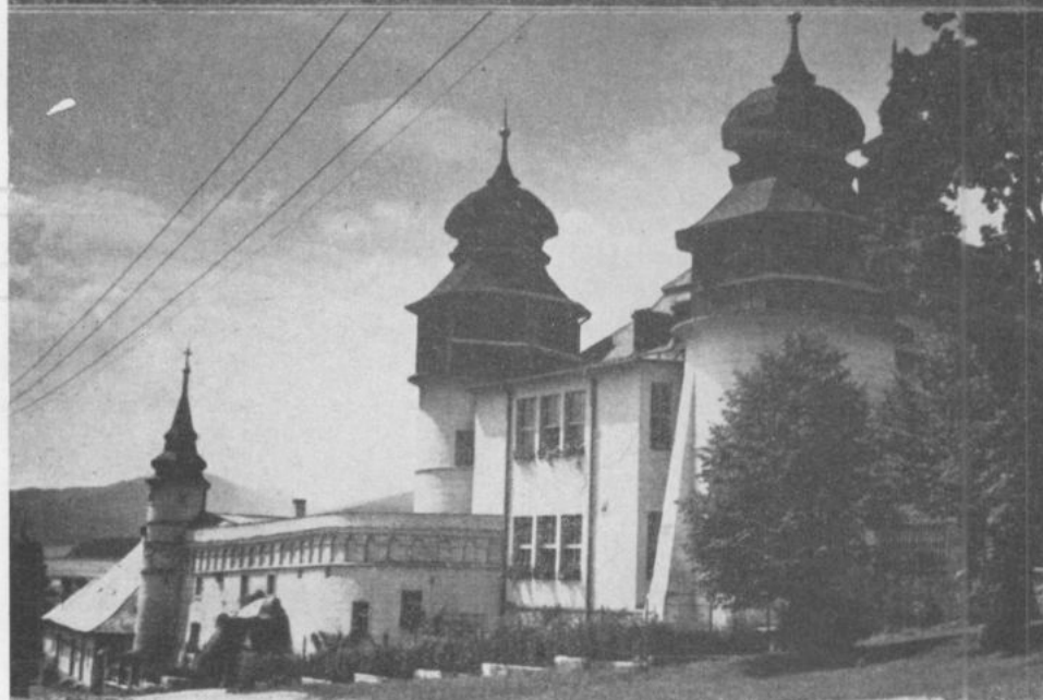
Bývalé letné sídlo spišských biskupov bolo po dôkladnej oprave odovzdané misijnej spoločnosti. Mohutné nárožné veže dodávajú kláštoru vzhľad opevneného renesančného hradu.
