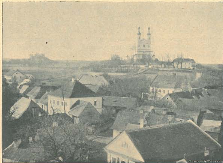
Pohled na poutní chrám na Chlumku u Luže.
