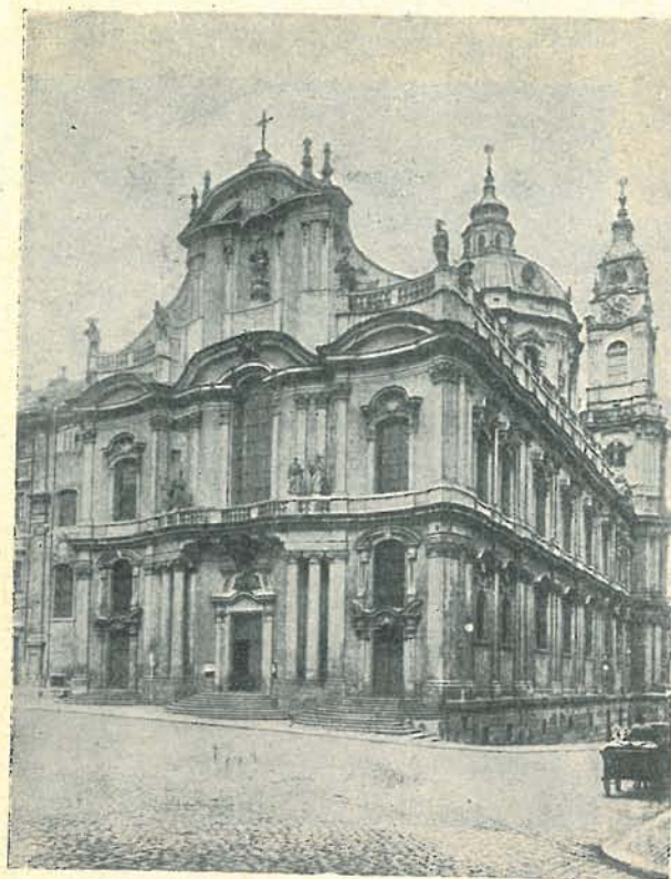
Obr. 25. Barokní chrám sv. Mikuláše na Malé straně v Praze (18. stol.). (Vpředu průčelí chrámu rozčleněné pilastry a sloupy po šířce, římsami do výše; vlnité štíty s atikou a balustrádou; bok chrámu, s řadou oken, zdobených vlnitými římsami; mohutná kopule nad skřížením lodí a věž.)
