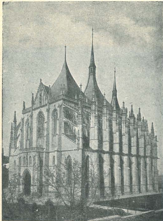
Obr. 18. Chrám sv. panny Barbory v Hoře Kutné (z 15. a 16. stol.). (Soustava podpěrných pilířů, zdobených filalami, a dvojnásobných opěrných oblouků; kolem střechy, vyběhající ve tři věže, galerie prolamovaná kružbami.)
