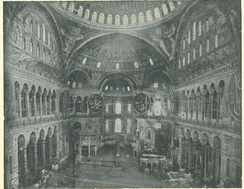
Obr. 12. Vnitřek chrámu Moudrosti Boží v Cařihradě. (V předu střední prostor, krytý kopulí; vzadu vedlejší prostor východní, krytý polokopulí; v něm dva výklenky a vprostřed apsida.)
