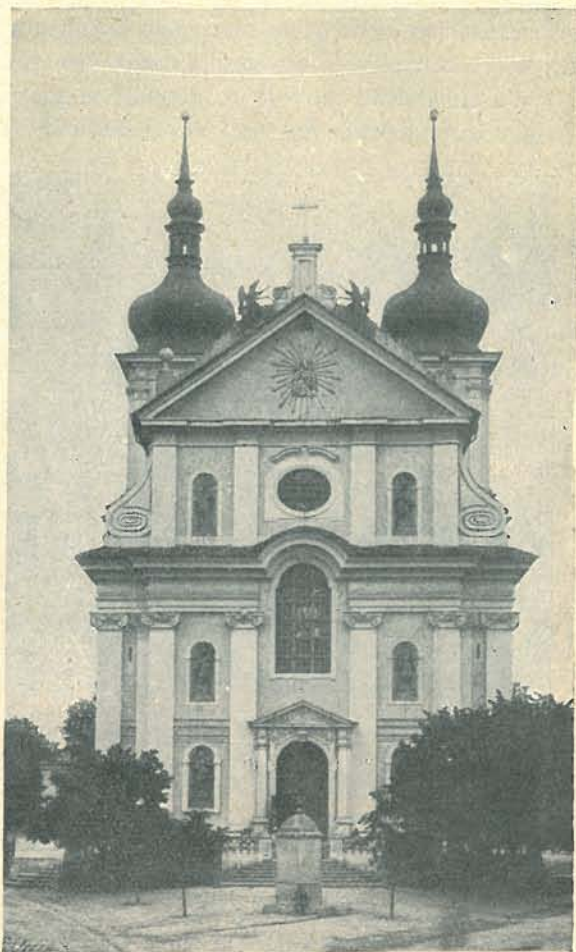
Obr. 22. Chrám poutní v St. Boleslavi (16. stol.). (Průčelí rozčleněno po šířce pilastry a do výšky římsami; ozdobeno výklenky se sochami, portálem a okny; zakončeno lomeným štítem; po stranách presbytáře dvě věže, nahrazující loď příčnou.)
